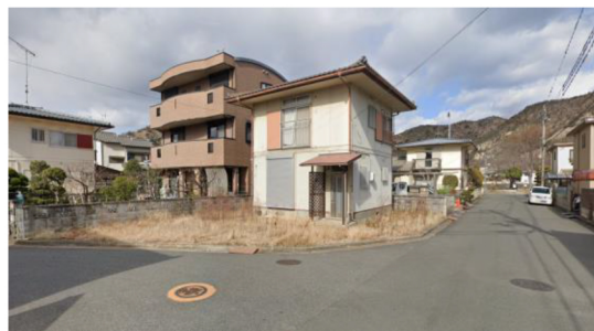
※建物解体中 12月10日解体完了予定
